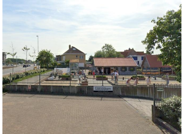
F2: Petanqueveld gezien vanaf de Franselaan
