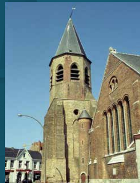
De huidige kerk is eigenlijk een samenvoegsel van 3 bouwfases.
