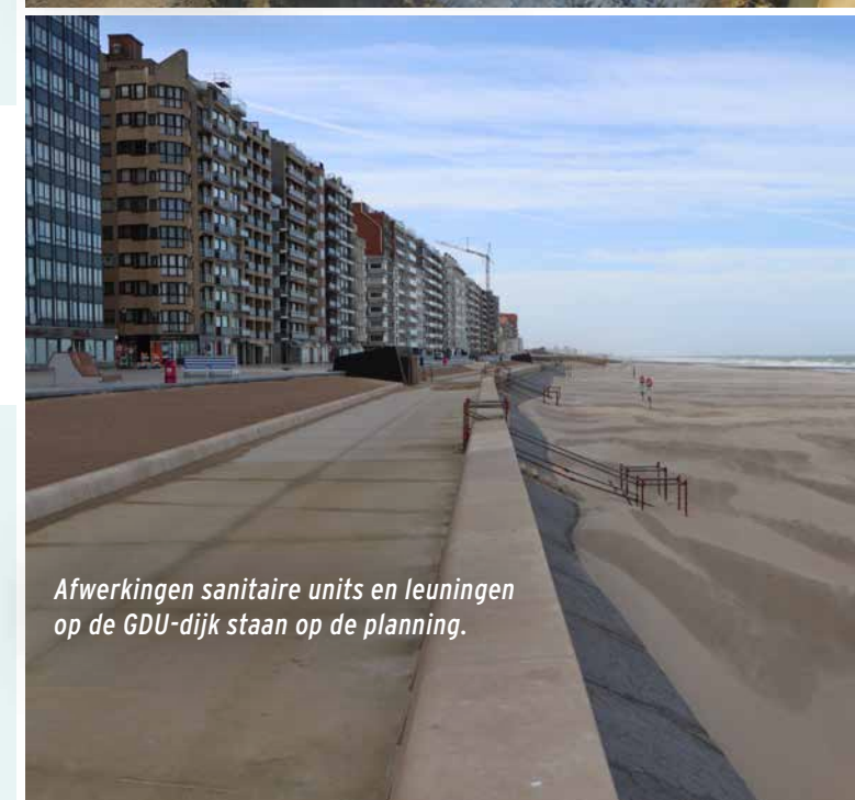
Imposante strandtoegang Rauschenbergplein in volle constructie
