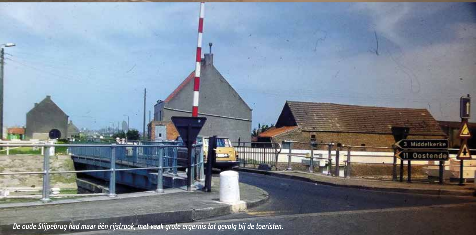
De oude en nieuwe ophaalbrug (in aanbouw) broederlijk naast elkaar
