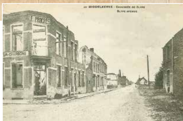
Zicht op de beschadigde Slijpesteenweg net na de Eerste Wereldoorlog. Links het toenmalige café annex kolenhandel 'Le Progrès' (nu bijgebouw gemeentehuis).
